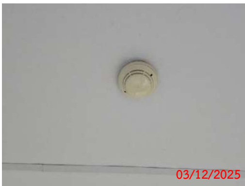
รูปที่ 2-24 เครื่องดักจับควัน
