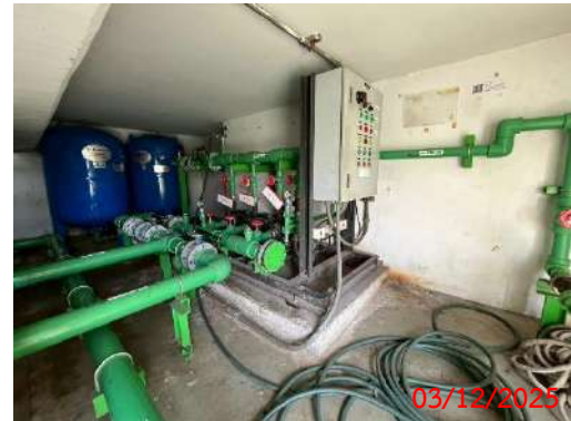
รูปที่ 2-47 ปั๊มน้ำใช้ ชั้นดาดฟ้า
